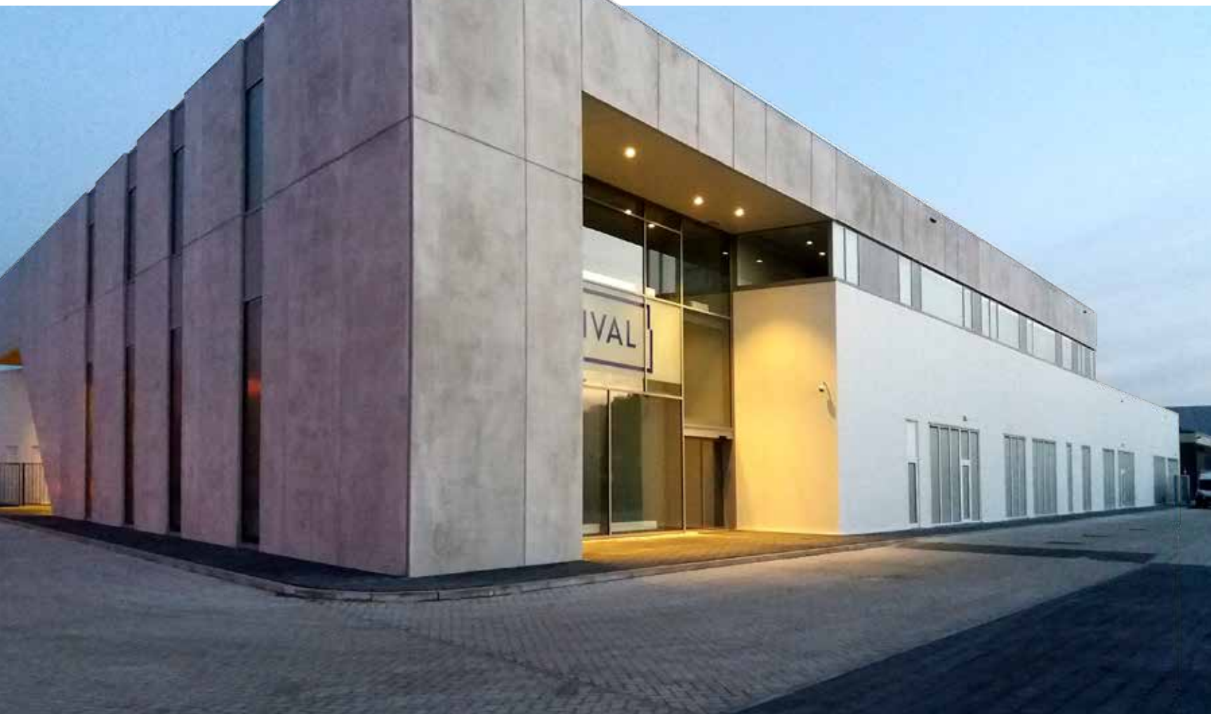
Het concept vormt een symbiose tussen het eerlijke, brute karakter van zichtbeton en de fijnzinnige detaillering van een cleanroom.
