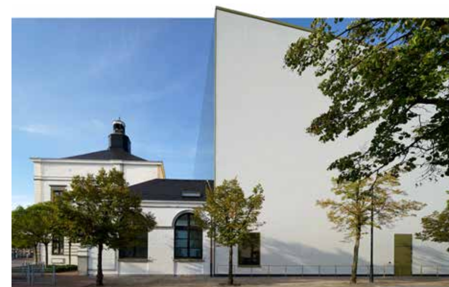
De zijgevels van het nieuwe gedeelte bestaan uit betonnen crepi met achterliggende isolatie.
