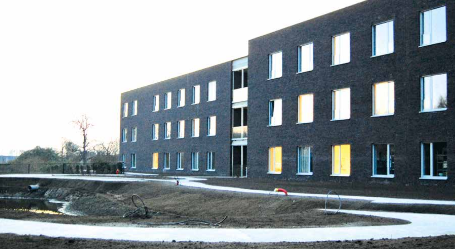
Het woonzorgcentrum heeft een eigentijdse, sobere gevel. Het wandelpark en de siervijver rond het gebouw worden deze winter aangelegd.
