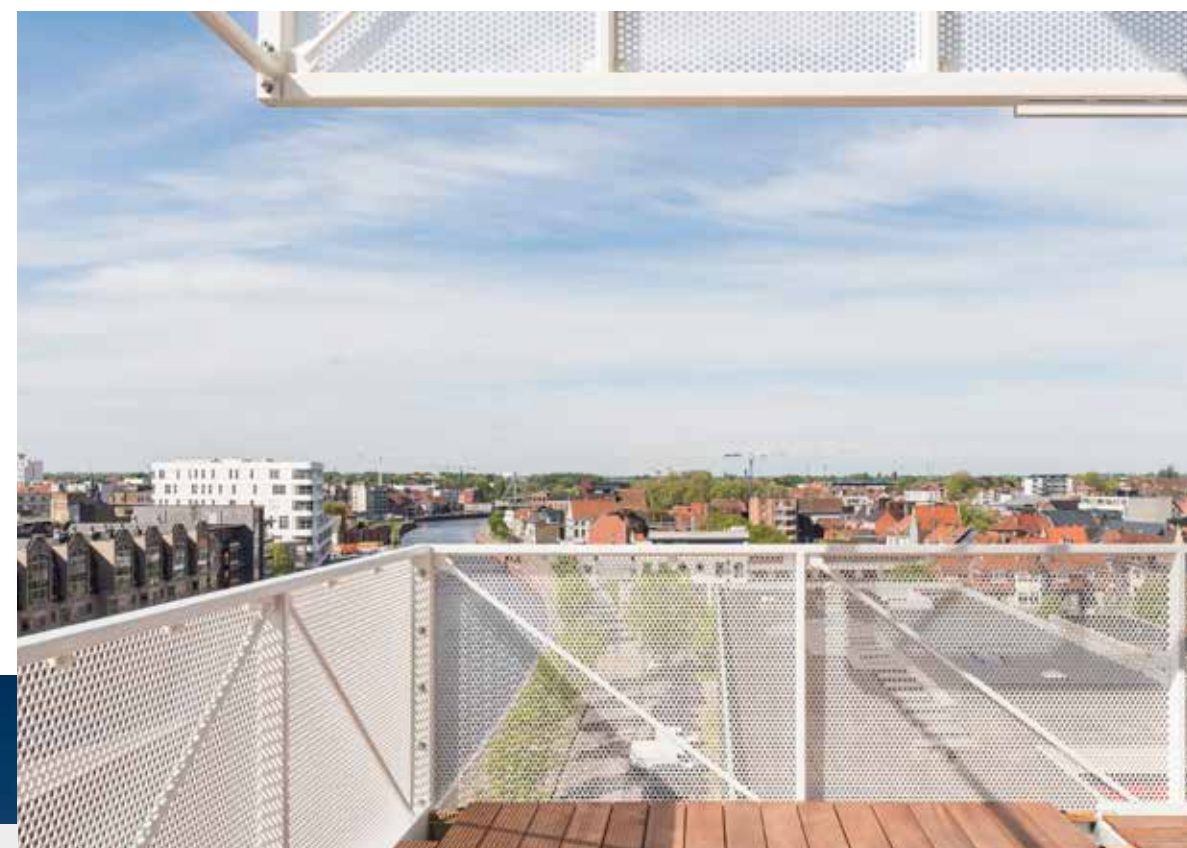
De witte metalen terrassen kregen een borstwering met geperforeerde platen en zijn afgewerkt met een hardhouten vloer.
