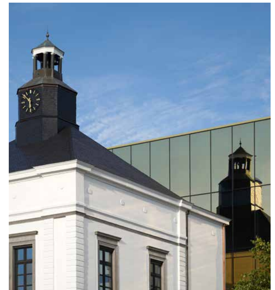
Het historische gedeelte wordt op een prachtige manier weerspiegeld in de vliesgevel van de nieuwbouw.
